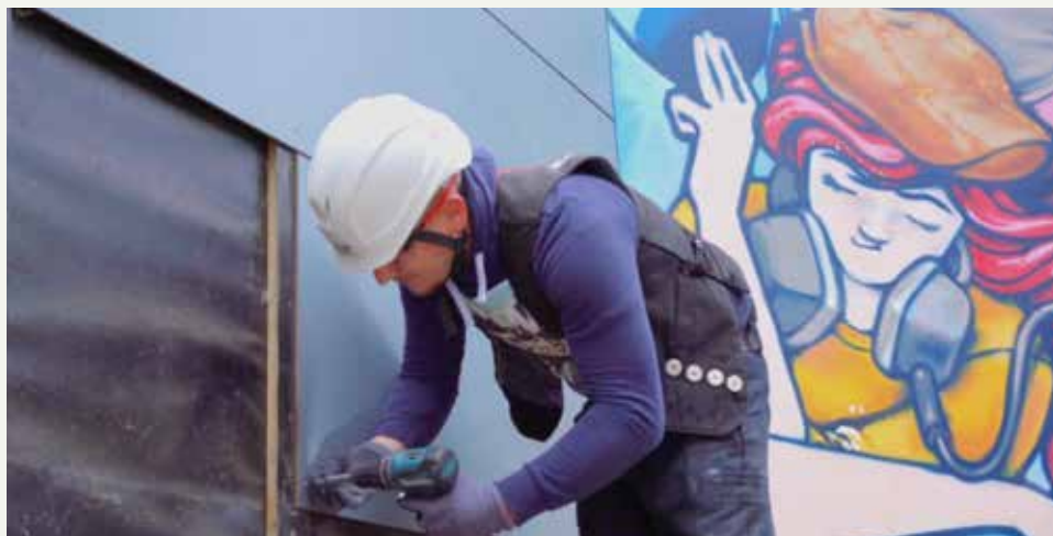
Enkel demontering av Rockpanel skivor
